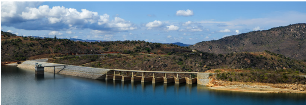
Embalse de Maguga en Suazilandia.
